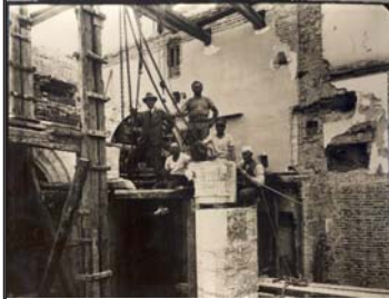
◀ Foto 4.2 Lavori per la costruzione della Scala Nova
